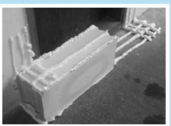
Nanesite poliuretansko peno v vrstah (črtah) na tla in steno (do višine zidaka), postavite prvi zidak tesno ob steni in ga pritisnite na tla.
